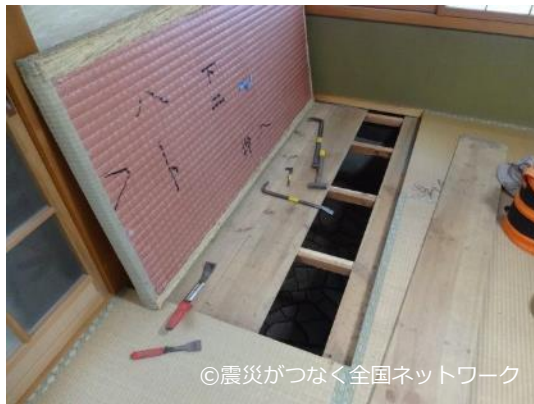
①和室の床板をはがす
